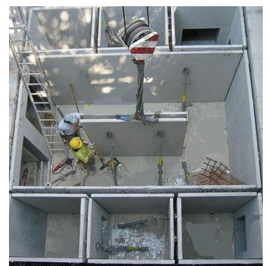
Pose en côtes bloquées
